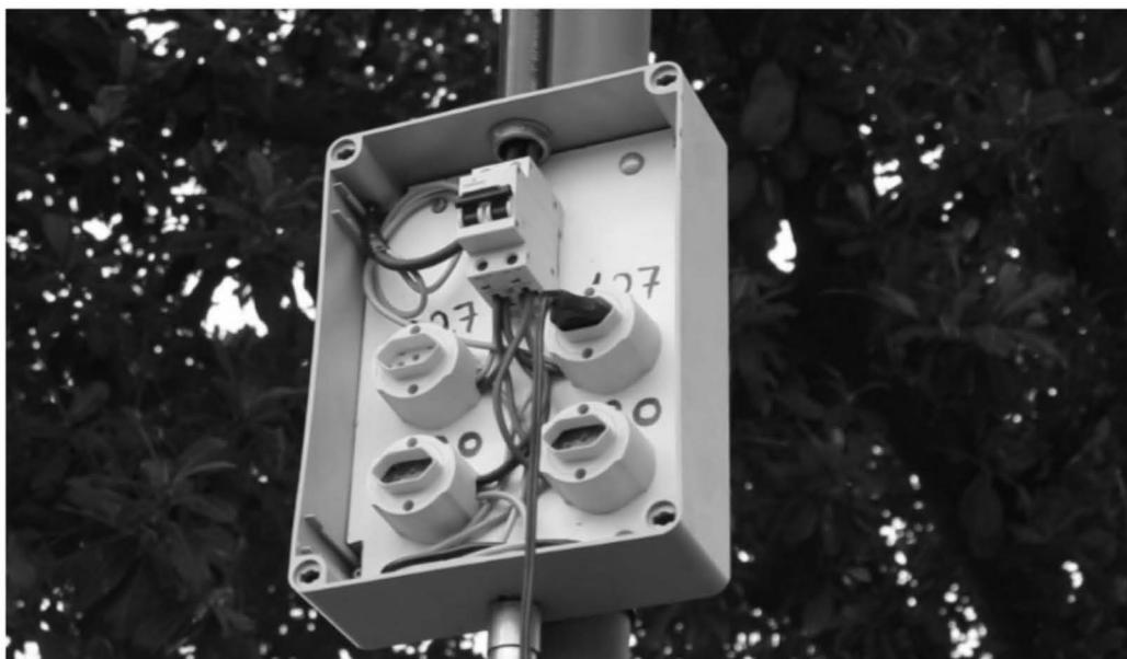
Postes de energia, com quatro tomadas cada um, tendo duas entradas de 127v e duas de 220v.
