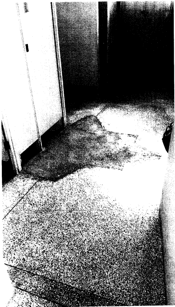
Área Interna, sala de uso exclusivo dos funcionários, necessitando de reparos.
