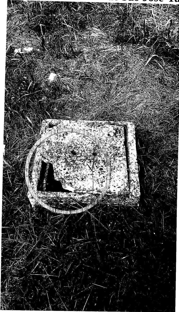
Área Externa lateral para Rua Malva e Rua Prímula com fossa com a tampa quebrada.
