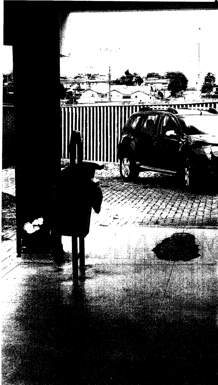
Área Externa/ Entrada necessitando de reparos tanto no piso, quanto nas paredes (pintura e manutenção).
